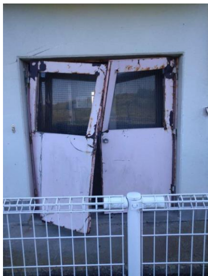
津波の力で変形した鉄の扉
